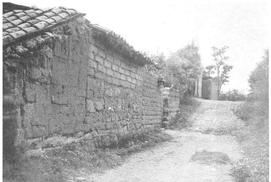
Tramo de una calle típica en Calpan. El pavimento tradicional consiste en arena de río para las partes planas y piedra bola para las cuestas.
