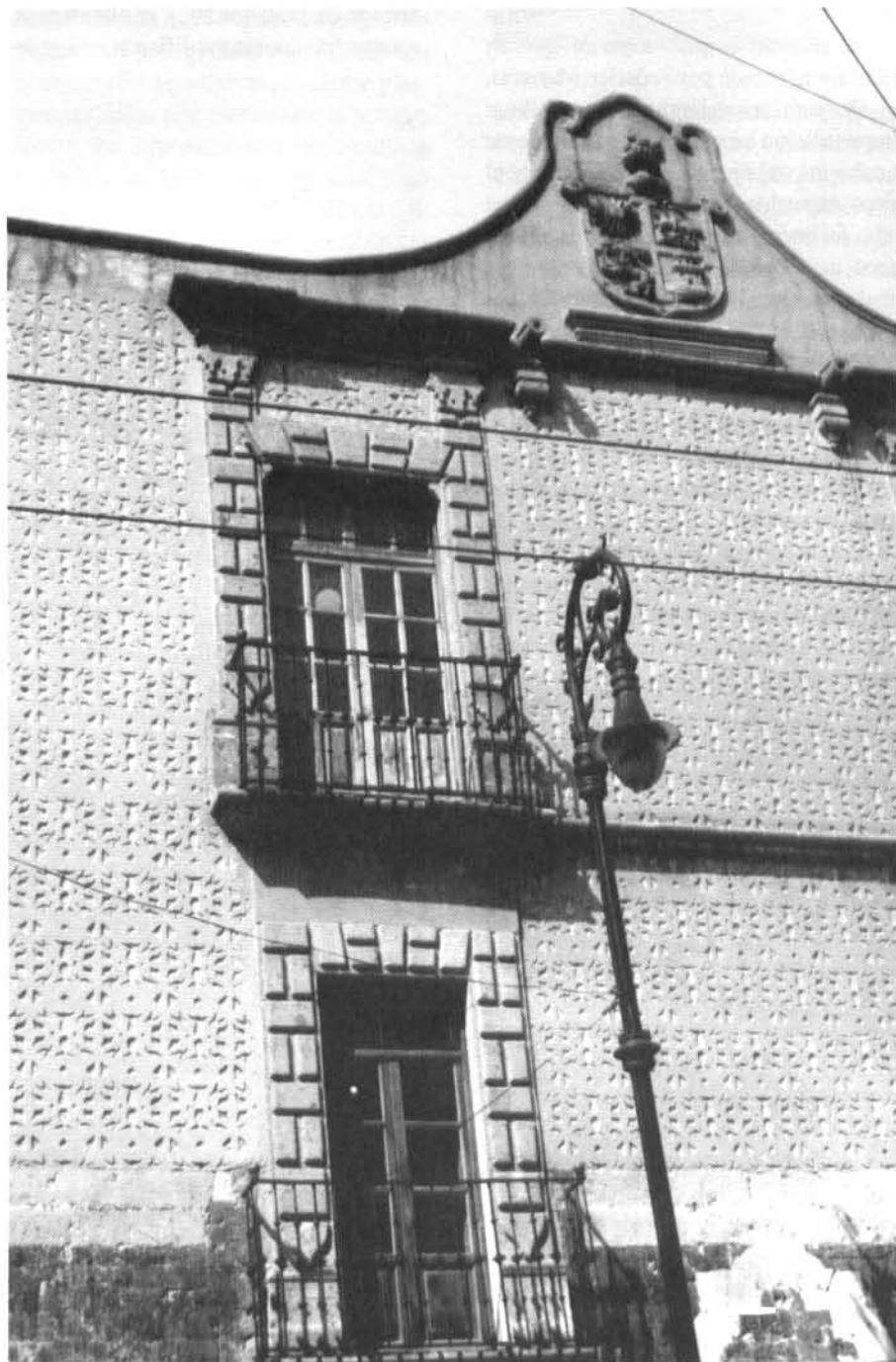
Casa en la calle de Isabel la Católica. Reconstruida recientemente esta casa nos permite conocer las características de la ornamentación arquitectónica del siglo xvii.
