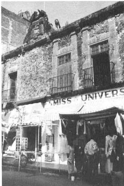
Casa en la calle de Honduras. Posiblemente sea la vecindad más antigua de la Ciudad de México. A pesar de que se encuentra habitada su estado es ruinoso y ha perdido sus ajaracas.
