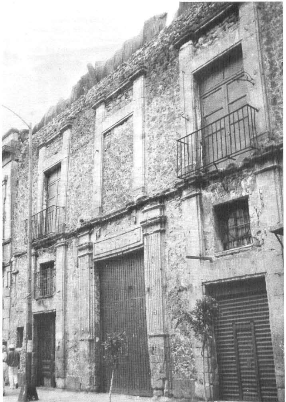
Casa en la calle de Mesones. Esta es otra de las joyas arquitectónicas abandonadas en riesgo de venirse abajo. Sus ajaracas ya no existen.
