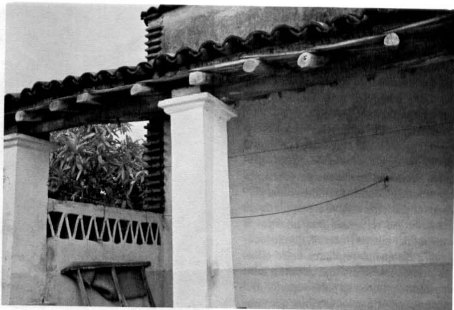
Detalle constructivo en una casa modesta.
