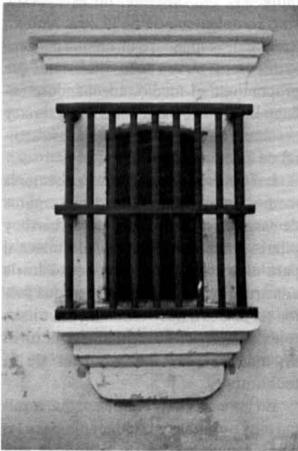
Ventana con postigos en una casa juchiteca.
