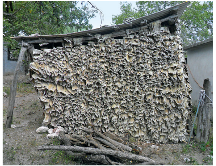
Figura 6. Casa de penca de maguey, lámina y piso de tierra. Fuente: PRONAI, Hábitat rural sustentable para regiones semiáridas.
