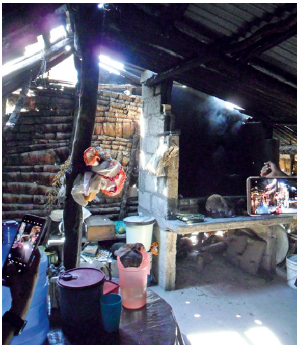
Figura 6. Casa de penca de maguey, lámina y piso de tierra. Fuente: PRONAI, Hábitat rural sustentable para regiones semiáridas.
