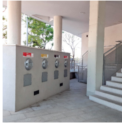
Figura 8. En cada edificio existen unos "buzones" donde los inquilinos depositan sus desechos ya clasificados, mismos que van a una planta de tratamiento. Fuente: ENVAC, "Las antiguas Colonias de San Francisco Javier...", op. cit.
