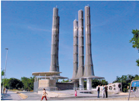
Figura 7. Estas chimeneas de 40 m de altura simbolizan ya al ecobarrio de Vallecas y en su base se encuentra la Central de Recogida Neumática del Ecobarrio de Vallecas. Fuente: ENVAC, "Las antiguas Colonias de San Francisco Javier...", op. cit.
