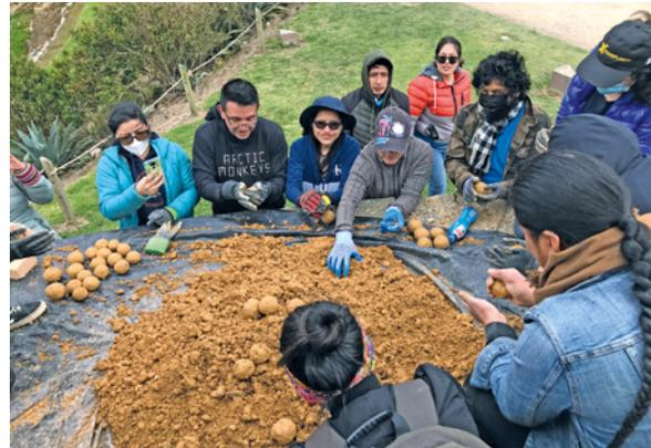
**Figura 11.** Elaboración de esferas para la consolidación con quillucaca estabilizada con cal. Fotografía: Luis Guerrero, 2022.
