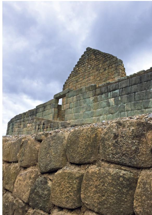
**Figura 5.** El muro sur de La Elipse y el frontis del "Cuerpo de Guardia" fueron desmontados y vueltos a colocar durante las intervenciones de los años setenta. Fotografía: Luis Guerrero, 2022.
