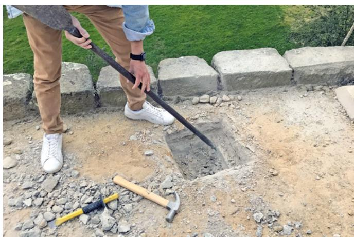
**Figura 9.** Descubrimiento del “zuncho” de concreto colocado a fines del siglo pasado en el perímetro superior de La Elipse. Fotografía: Luis Guerrero, 2022.
