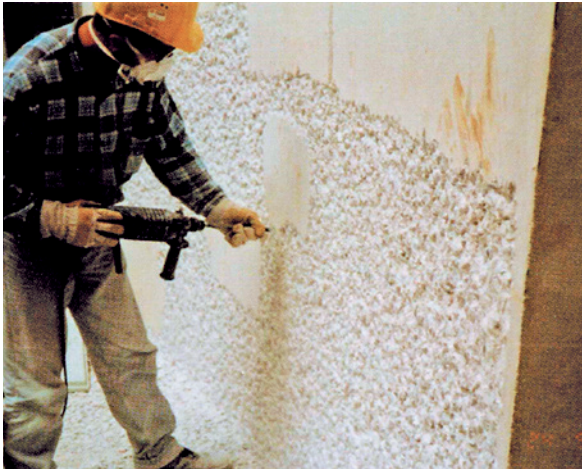
Figura 19. Casa González de León, picleteado del concreto. Fuente: Ibid. , p. 234.
