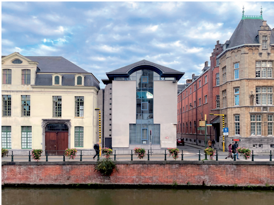
Edificio de uso mixto con características posmodernas en la orilla del canal Reep.
