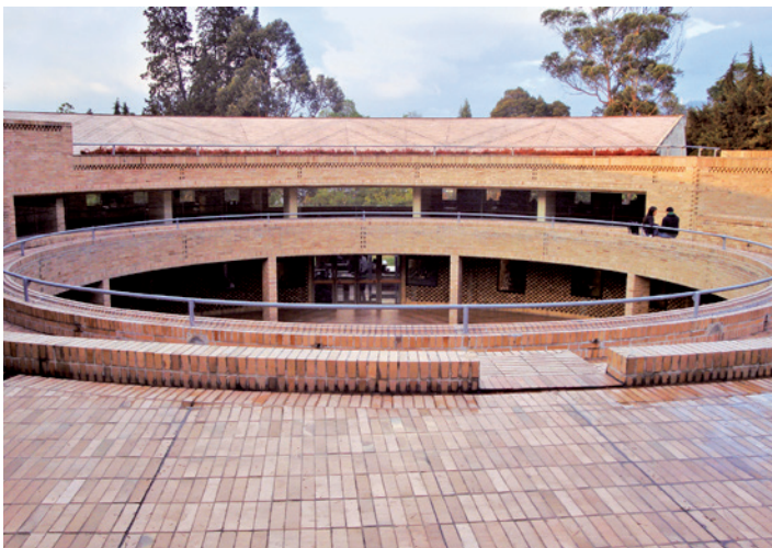
Figura 8. Edificio de Posgrados, Facultad de Ciencias Humanas, Universidad Nacional de Colombia, Bogotá. Fotografía: ©JAC.
