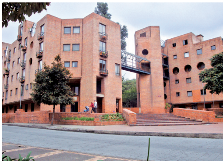
Figura 4. Conjunto de Viviendas Nueva Santa Fe, Bogotá. Fotografía: ©JAC.
