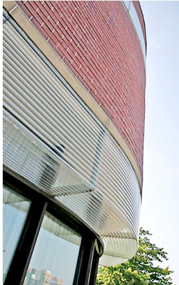
**Figura 56.** Detalle de la esquina en la conexión (con tubos Pyrex) entre los elementos verticales y el entrepiso. Fuente: <https://bit.ly/3xiU3UI>.
