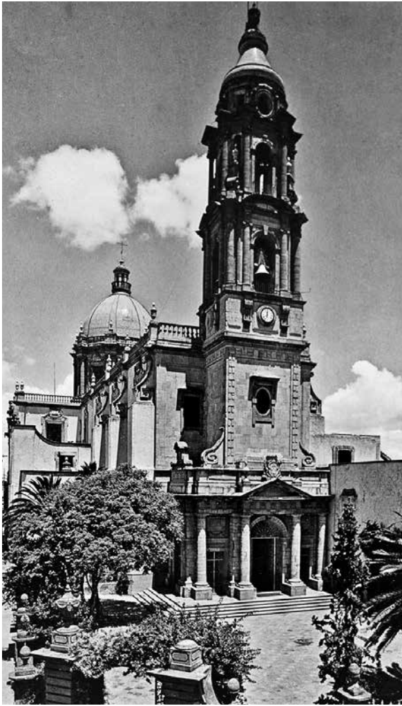
Figura 12. Fachada principal de la iglesia del Carmen, Celaya, Guanajuato. Fuente: Fototeca Manuel Toussaint del Instituto de Investigaciones Estéticas.
