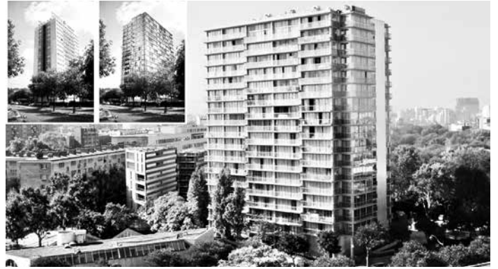
Figura 19. Esta torre de vivienda parisina de los años 60 del siglo pasado fue remodelada en su fachada mediante una extensión de un par de metros en todo su perímetro. En este caso la prioridad no era conservar el edificio por su carácter arquitectónico, sino más bien mejorar las condiciones de vida de sus habitantes con espacios más dignos y funcionales. El discurso de los arquitectos fue nunca demoler, sino aprovechar lo existente y aportar, a partir de ello, un mejor lugar de vida. Fuente: http://img.gawkerassets.com/img/18kaq2zsl2dsjpg/original.jpg .
