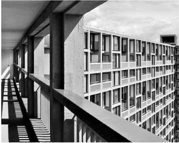
Figura 18. Los pasillos de acceso o "calles en el cielo" como se denominaron desde su origen, se conservaron, al igual que los barandales de concreto que fueron rehabilitados en su totalidad pues se trataba de elementos característicos del proyecto inicial que da identidad al inmueble. Fuente: www.architravel.com/architravel/building/park-hill/ .
