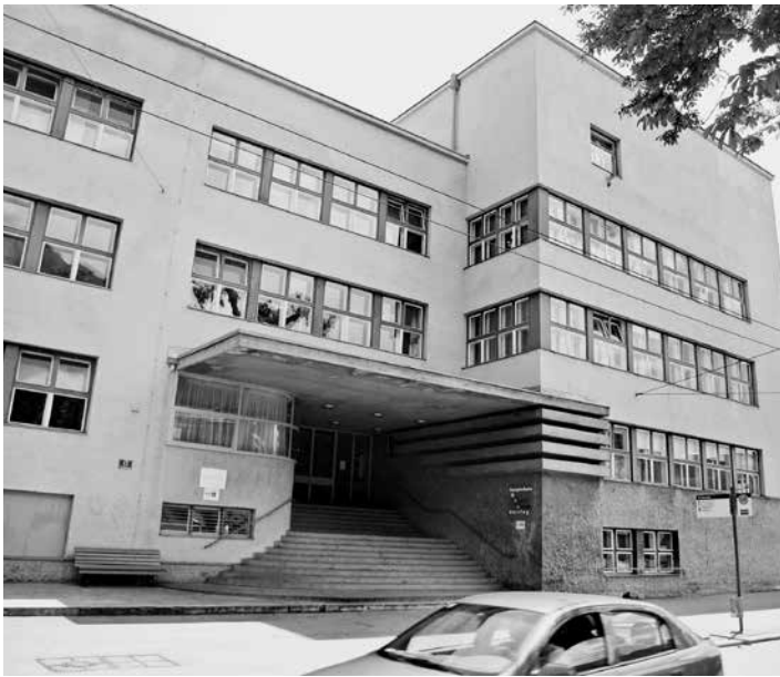
Figura 15. Este inmueble escolar ubicado en Austria fue declarado patrimonio del siglo XX y requirió la intervención sobre su envoltorio para mejorar su rendimiento térmico sin comprometer su carácter arquitectónico original. El trabajo incluyó la incorporación de ventanas interiores más eficientes en cuanto a hermeticidad, sin afectar la fachada y su cancelería original. Fuente: www.3encult.eu/en/casestudies/default.html .
