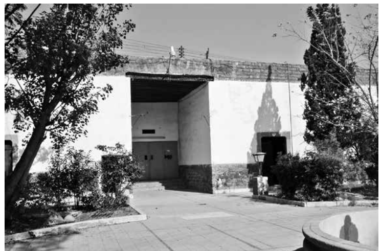
Figuras 9 y 10. El patio principal de acceso antes y después de su intervención. El proyecto optó por un patio mucho más austero, sin más elementos que el pavimento pétreo con un juego de desniveles. Las crujías circundantes albergan dependencias administrativas, locales de venta y servicios de apoyo al Centro Cultural. Fotografías: FJSL.
