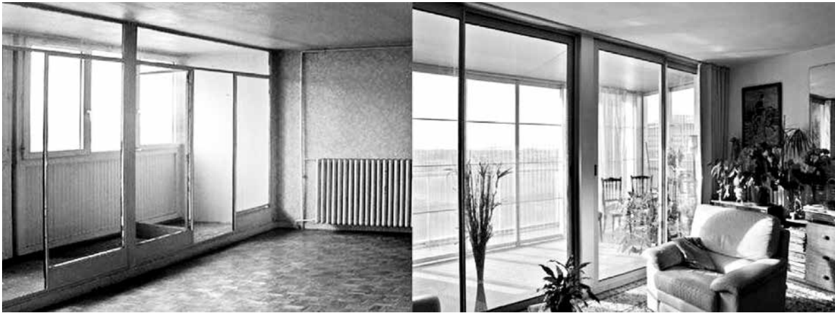
Figura 20. Vista del antes y después de la intervención en La Tour Bois-Le-Prêtre. El proyecto no sólo buscaba dar mayor superficie a los departamentos, sino también crear un mejor microclima interior para los mismos, pensando en optimizar las condiciones de confort térmico, ventilación e iluminación en beneficio de los habitantes, la mayor parte de ellos personas de la tercera edad. Fuente: https://goo.gl/HW4u6k .
