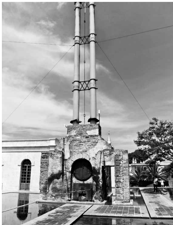
Figura 5. Las tipologías arquitectónicas susceptibles de ser reutilizadas, rehabilitadas o reconvertidas se han ampliado mucho en las décadas recientes, entre otras cosas por la influencia del discurso del desarrollo sostenible. Vista de la ex-fábrica de Hilados y Tejidos La Soledad fundada en 1883, ahora reutilizada como Centro de las Artes de San Agustín, el primer centro de las artes ecológico de Latinoamérica. Fotografía: Francisco Javier Soria López (FJSL).
