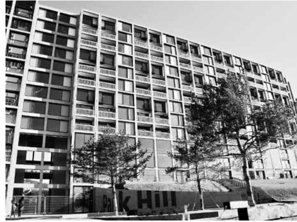
Figura 17. La intervención en el conjunto redefinió el uso de los primeros tres niveles para ser destinados a comercio y oficinas, con actividades colectivas que complementarían a la vivienda. Los muros de ladrillo fueron sustituidos con paneles de colores y ventanales mucho más amplios que los originales, lo que trajo un cambio importante en el discurso arquitectónico de las fachadas. Fuente: www.skyscrapercity.com/showthread.php?t=1516046&page=8 .
