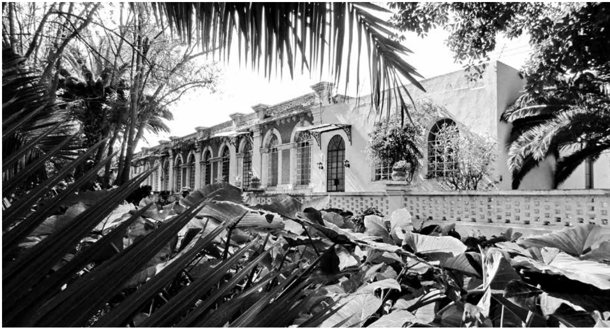
Figura 21. Vista de habitaciones dentro del conjunto fabril. Fotografía: LRM.
