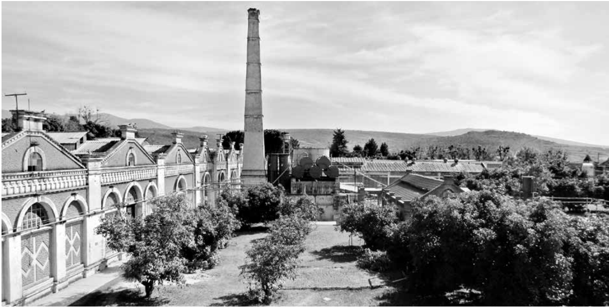
Figura 14. Vista del conjunto Fabril. Fotografía: LRM.
