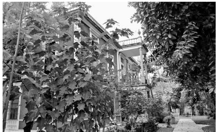
Figura 3. Casa Mayor ubicada en el conjunto fabril. Fotografía: LRM.
