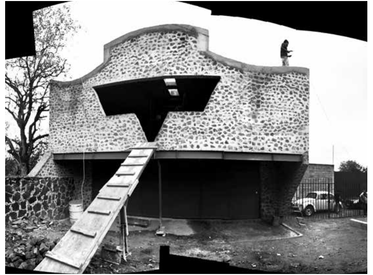
Figura 30. Estructura de concreto ciclópeo y bóvedas de tierra estabilizada. Magdalena Petlalcalco, Tlalpan. Proyecto y edificación: Jaell Durán e Isaac López. Fuente: Archivo de Isaac López y Jaell Durán.
