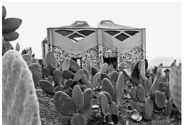
Figura 25. Muros de piedra que proporcionan resistencia al cortante. Proyecto y edificación: Mario Larrondo, Isaac López y Jaell Durán. Casa "El Abrazo" en Totolapan, Morelos. Fuente: Archivo de Jaell Durán e Isaac López.
