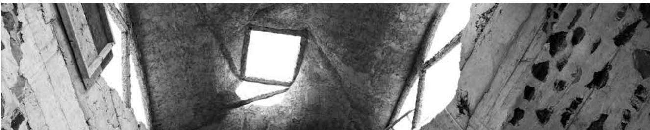
Figura 28. Cubiertas de tierra, con la mínima cantidad de acero y cimbra. Proyecto y edificación: Mario Larrondo, Isaac López y Jaell Durán. Casa en Totolapan. Morelos. Fuente: Imagen del archivo de Isaac Díaz Landeros.
