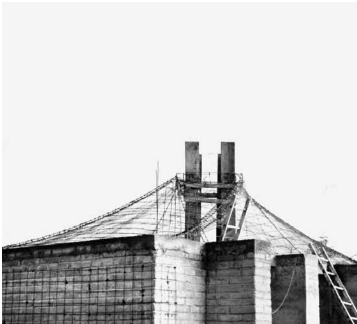
Figura 27. Cubiertas de tierra, con la mínima cantidad de acero y cimbra. Proyecto y edificación: Mario Larrondo, Isaac López y Jaell Durán. Módulo en el predio de Las Ánimas. Fuente: Archivo de Jaell Durán e Isaac López.
