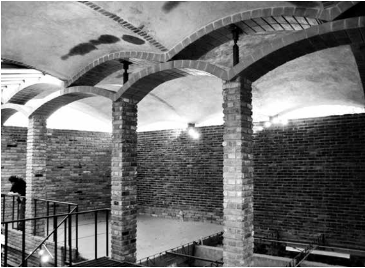
Figura 29. Bóvedas gausas o de doble curvatura en la Ludoteca, en Petlalcalco. Proyecto y edificación: Mario Larrondo, Isaac López y Jaell Durán. Fuente: Archivo de Isaac López y Jaell Durán.
