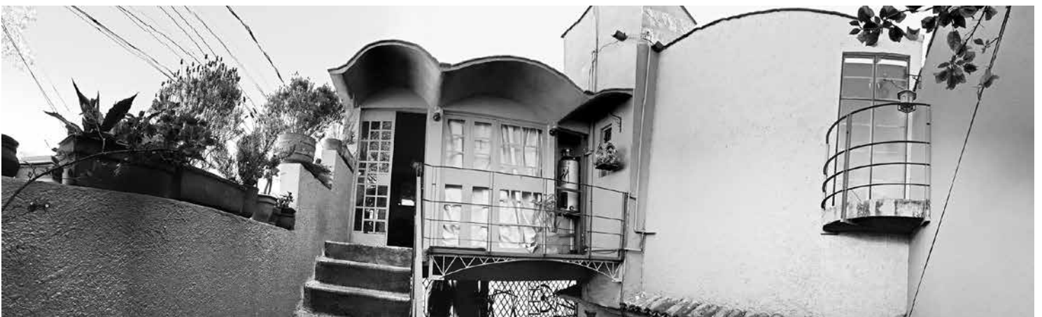
Figura 32. Bóvedas de tierra armada, casa Unidad Modelo. Proyecto y edificación: Jaell Durán e Isaac López. Fuente: Archivo de Isaac López y Jaell Durán.
