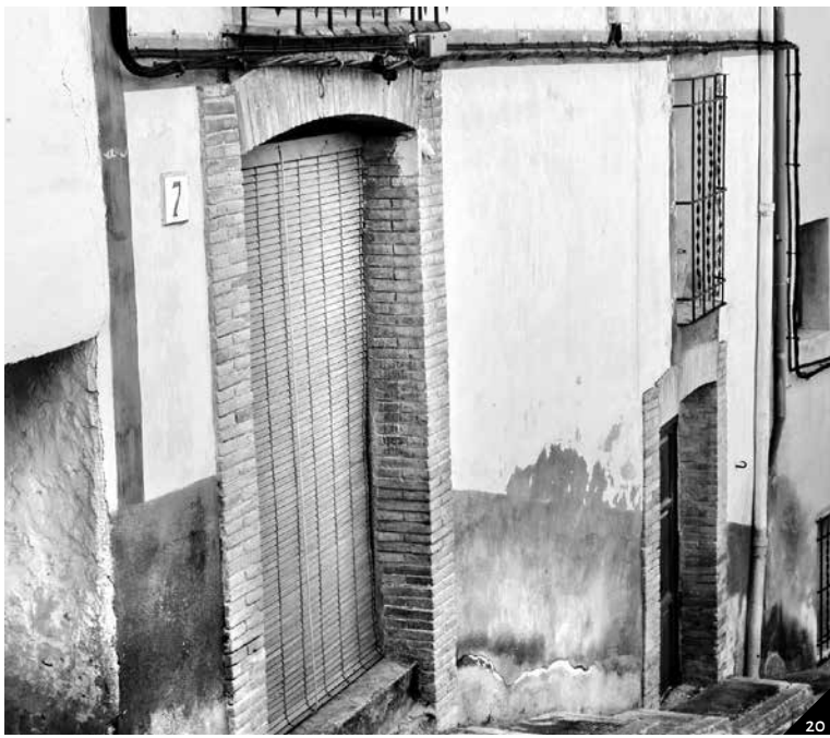
Figuras 18 a 20. Jambas, dinteles, balcones y rejerías característicos.
