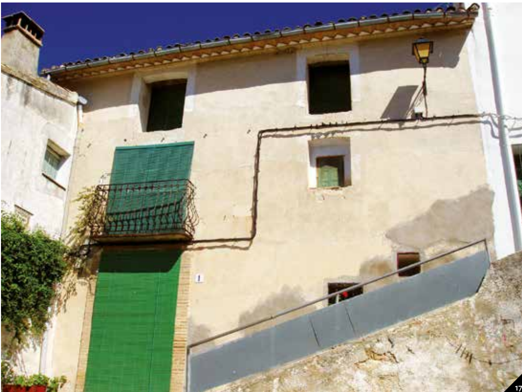
Figuras 15 a 17. En general, las viviendas salvan fuertes pendientes con sus tres plantas (de diferente rango y función). Se observa el característico arco adintelado, ocultado por el enlucido.
