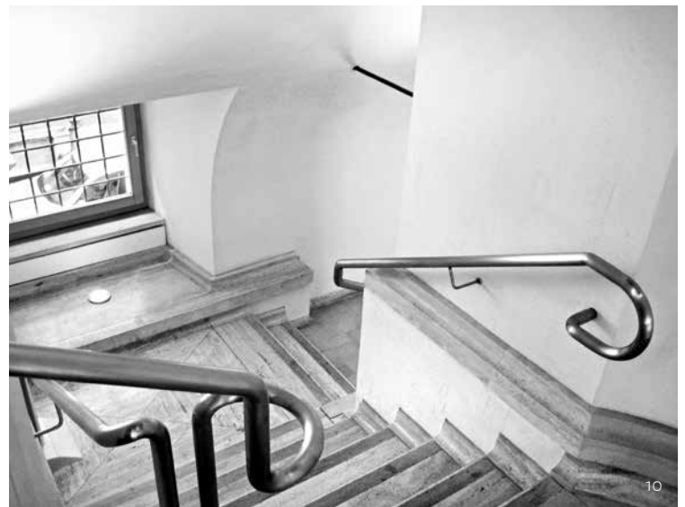
Figuras 8 a 10. Detalles de la nueva escalera que comunica a los tres niveles del museo. Fotografía: Leonardo Meraz.
