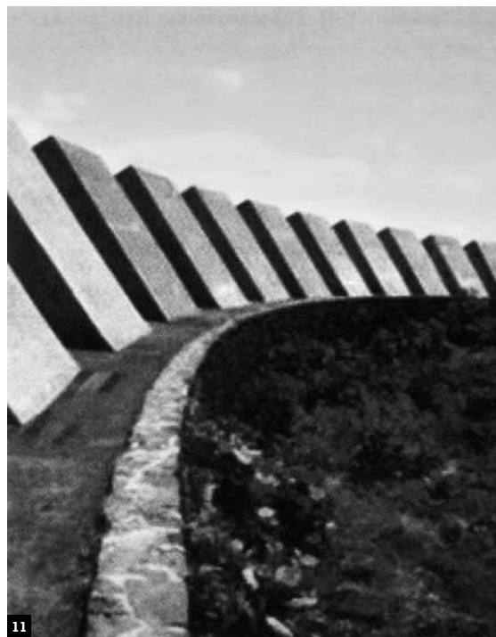
Figura 7 Envolvente de lámina en la Torre de Ingeniería. Foto: SEG.
