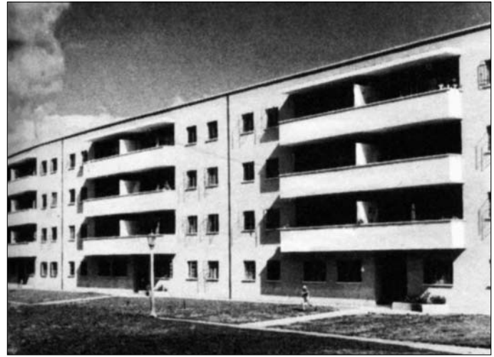
Figura 8. Unidad Vecinal Coronel Carlos Delgado Chalbaud, 1949-1950, Carlos Raúl Villanueva, Banco Obrero, Caracas. Banco Obrero, La vivienda popular en Venezuela 1928-1952 , Caracas, 1952.
