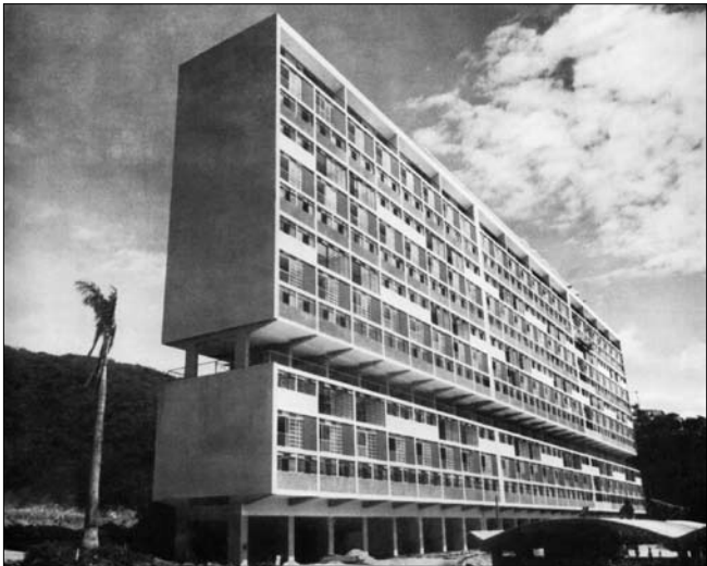
Figura 9. Unidad de Habitación Cerro Grande, 1952-1954, Guido Bermúdez, Banco Obrero, El Valle, Caracas. Unidad de Habitación. Solución al problema de la vivienda , Banco Obrero, Caracas, s/f.
