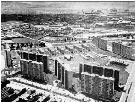
Figura 3. Conjunto Urbano Antonio Nariño, 1952- 1958, arquitectos Néstor C. Gutiérrez, Daniel Suárez Hoyos, Rafael Esguerra García, Enrique García Merlano, Juan Menéndez. Ministerio de Obras Públicas, Bogotá, Revista Arquitectura , sff.
