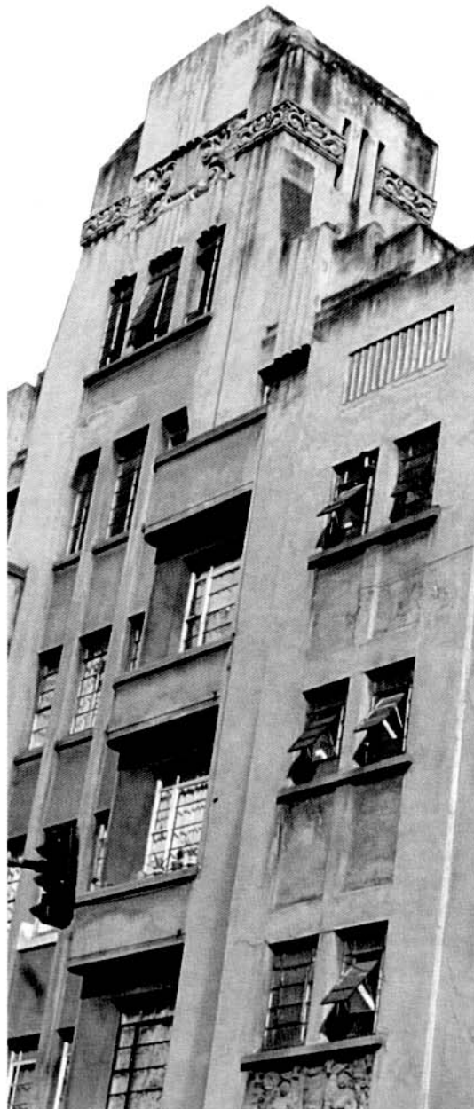
Foto 1. ESQUINA DE LÓPEZ Y VICTORIA. EDIFICIO VICTORIA.
