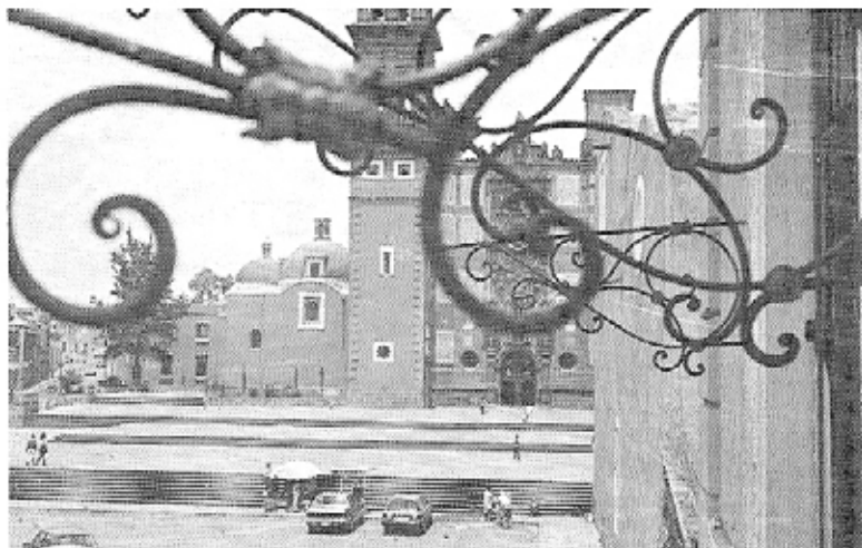
FACHADA PRINCIPAL DE LA IGLESIA DE SAN FRANCISCO.
